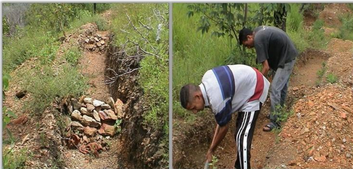
Foto 2: Implementación de Zanjas de Adsorción y Trincheras de Piedra como Estrategia de Cosecha de Agua y Mitigación de la Erosión en la Cooperativa Agrícola Forestal El Valle, R. L. Cuenca Alta del Río Guárico, Parroquia Tucutunemo, Sector Los Bagres y El Onoto, estado. Aragua.
