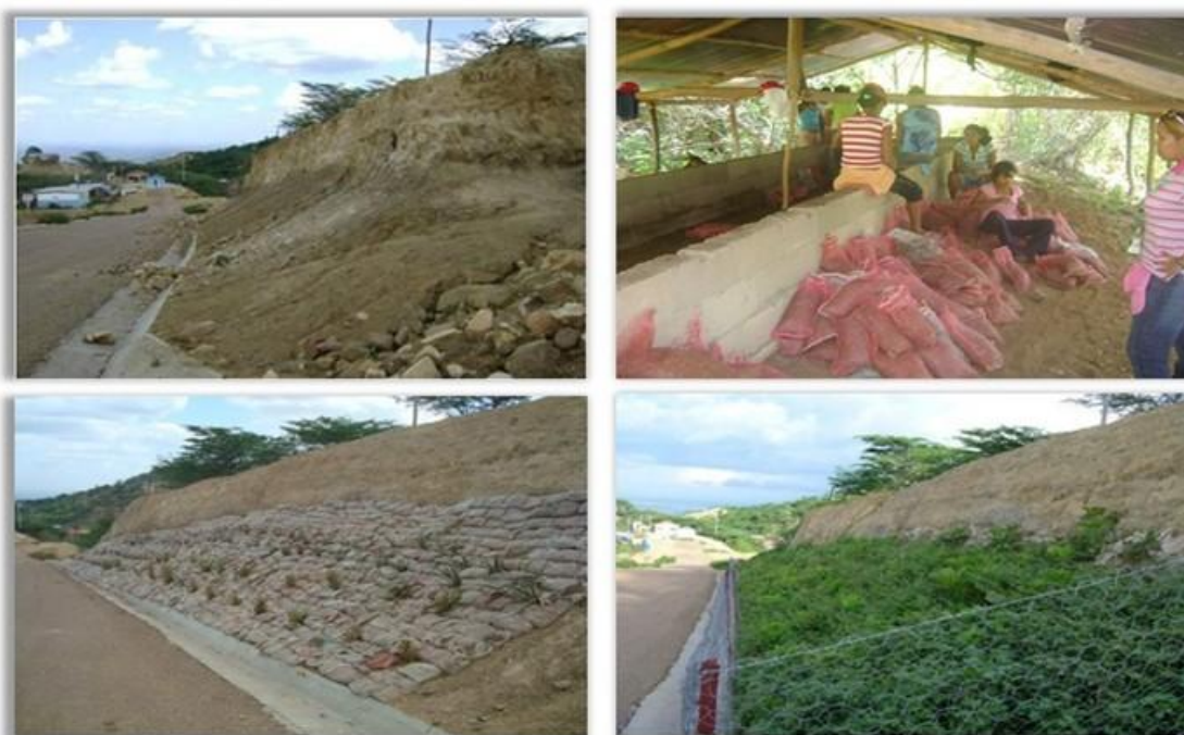
Foto 1: Diseño e Implementación de Celdas Nutritivas con Enmiendas Orgánicas para la Rehabilitación Fitoecológica de Taludes en Alto de Cambural en el estado Anzoátegui.
