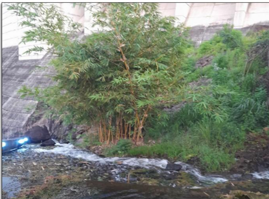
Foto 4: El Bambú, es reconocido por su utilidad para estabilizar taludes y controlar la erosión, además mejora la salud del suelo al aumentar la materia orgánica y la infiltración. Se observa la planta de Bambú alledaño al Central Hidroeléctrica Simón Bolívar (Guri), ubicada en el estado Bolívar, Venezuela.
